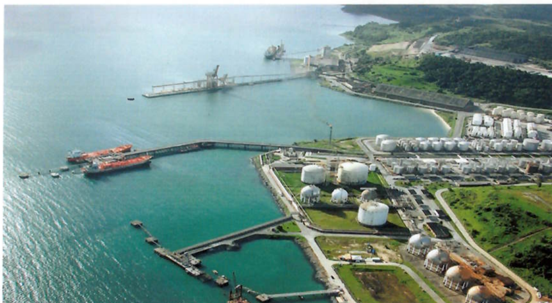
Figura 3.2 Vista do Terminal Marítimo de Aratu.
